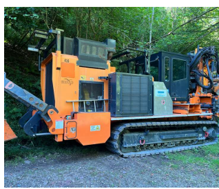
Quartier Gerasto, secteur Harlepoo, renforcement et enfouissement des réseaux électriques par TE64
