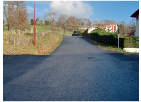
Une vue de la RD 349 dégagée des réseaux aériens
