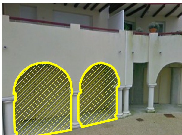
Obturation d'une travée de galerie
