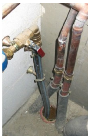
Exemple d'entrées de réseaux à calfeutrer
